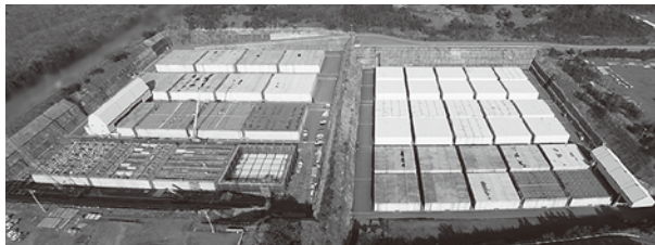
図11 日本原燃株式会社の低レベル放射性廃棄物埋設センター 出典: 日本原燃株式会社ホームページ 埋設事業より転載 (URL: http://www.jnfl.co.jp/business-cycle/llw/ )
