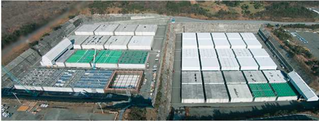
低レベル放射性廃棄物埋設センター(2014年撮影)
